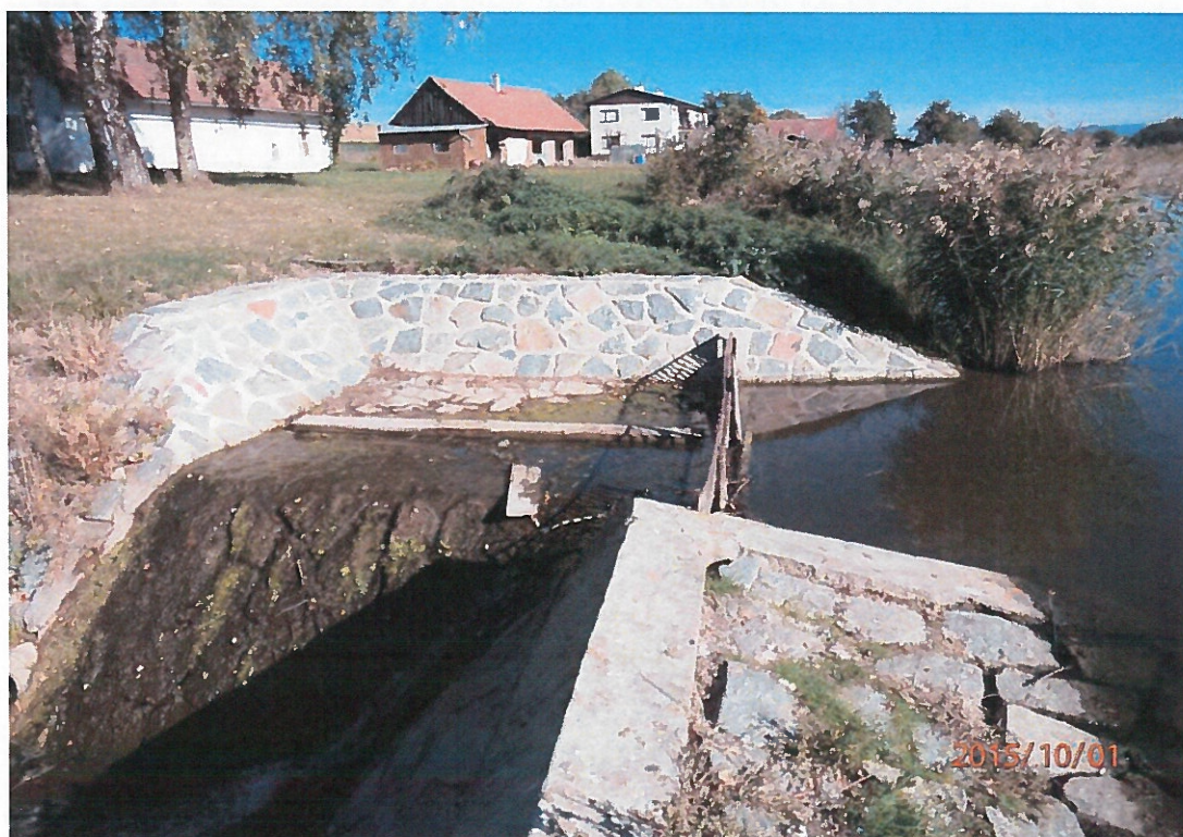
Detail bezpečnostního přelivu s viditelnými spárami v kamenné rovnatině na nátoku
