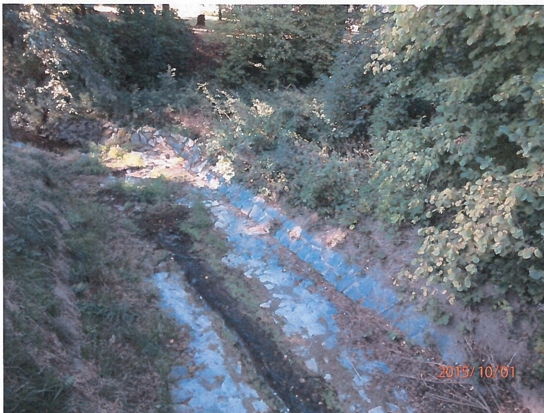
Opevněné koryto od bezpečnostního přelivu v podhrází s patrným přítokem z pravé strany.
