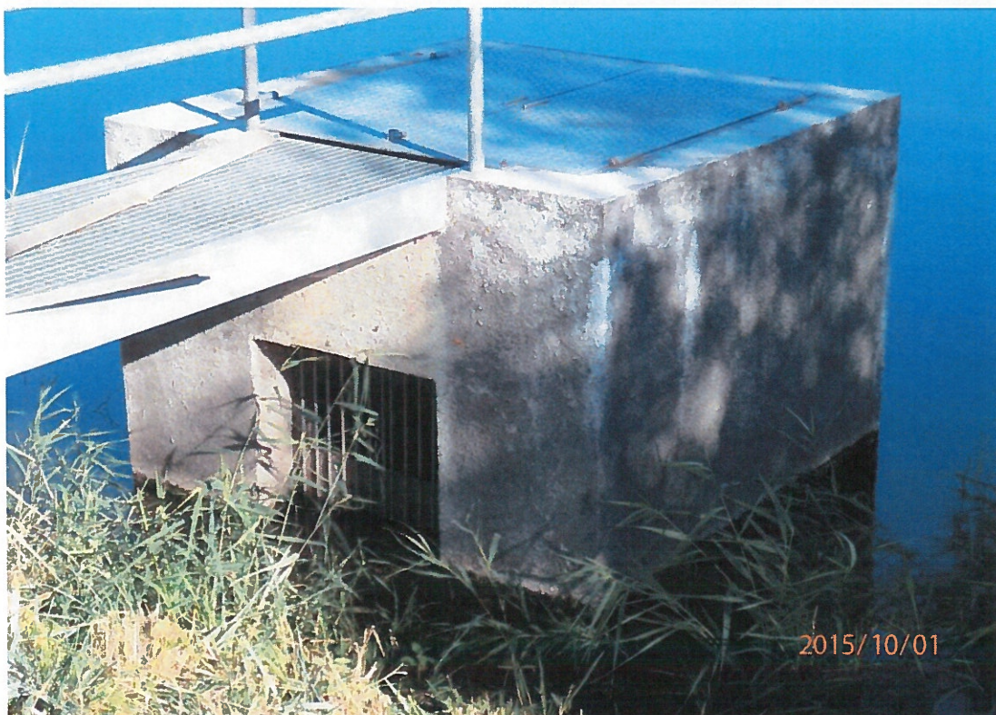
Stávající výpustné zařízení s přístupovou lávkou.
